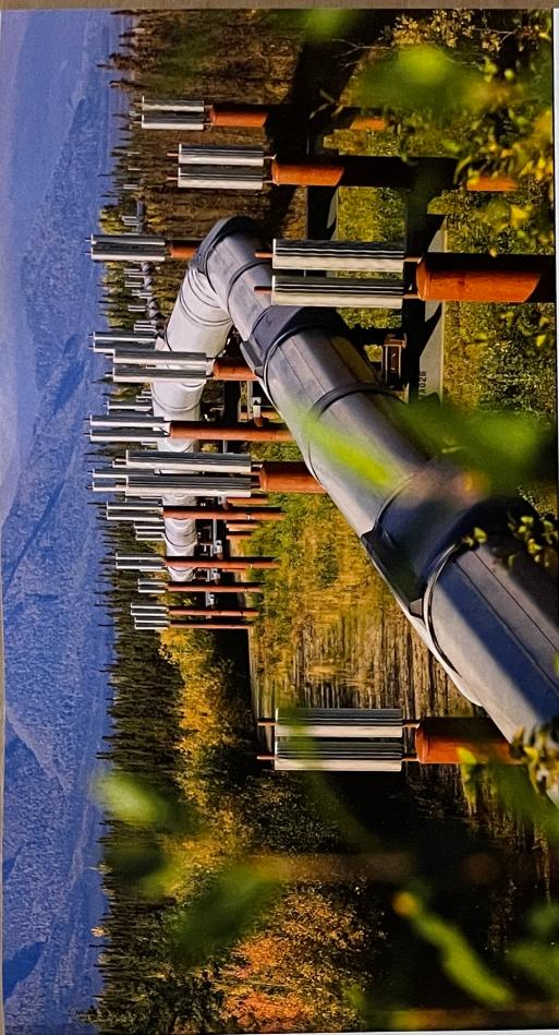
Die Trans-Alaska-Pipeline verläuft über weite Strecken auf Steinen. Die unterirdische Strecke ist stark wärmeisoliert, sonst würde das 50 bis 80 Grad warme Öl den Permafrostboden auftauen und die Pipeline im Schlamm versinken.
